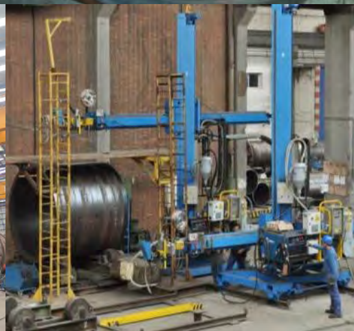
Сварка продольным швом
